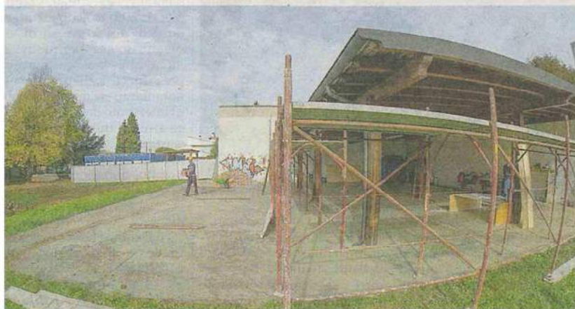
cantieri al Ceccato per la realizzazione della nuova ala per aule e laboratori. FOTOSERVIZIO MASSIGNAN
